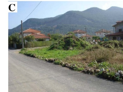
Figura 2. Ejemplos de alteraciones antrópicas en el medio fluvial de Liendo: A) ocupación de la margen izquierda del arroyo Hazas, B) edificación y muro de hormigón en zona de surgencia, y C) rellenos antrópicos en la llanura aluvial de Villanueva.
